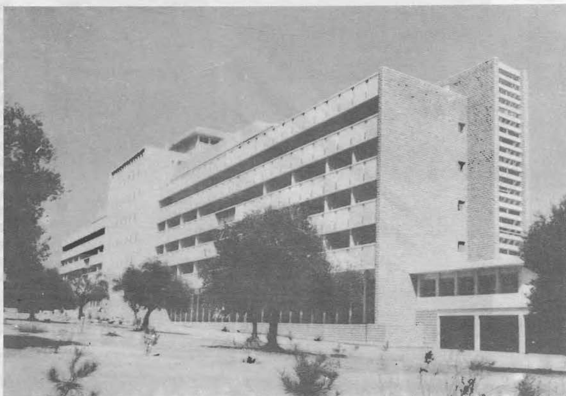
• المبنى الرئيسي للمستشفى
