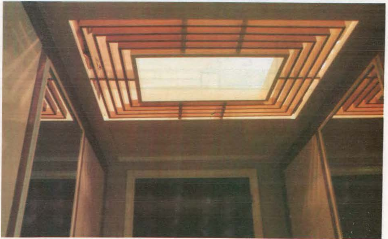
• تفصيلة وحدة الإضاءة بسقف ركن اللبس
