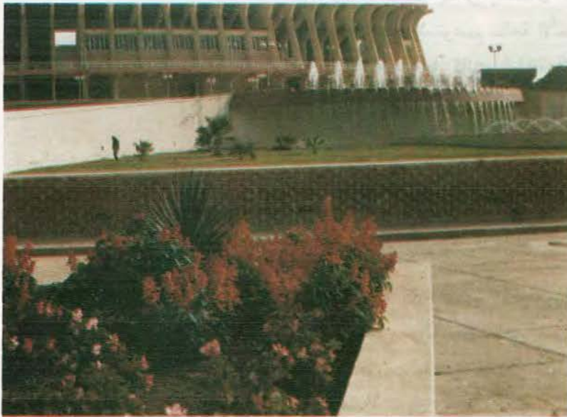
• منظر خارجي للمبنى يوضح جناح المدرجات والنافورات بالمدخل الرئيسي .
