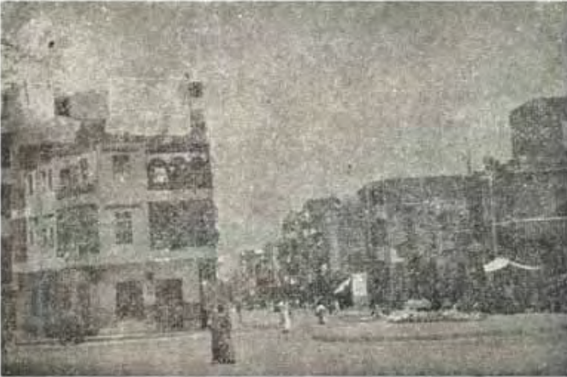
أثر البيئة على الشوارع في أحياء القاهرة القديمة
