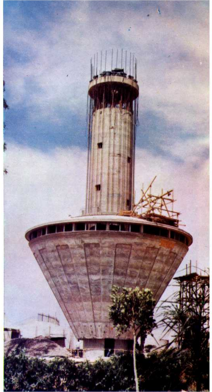
(١) حلة خزان مياه الجبل الاخضر بعد صبها على الارض .
